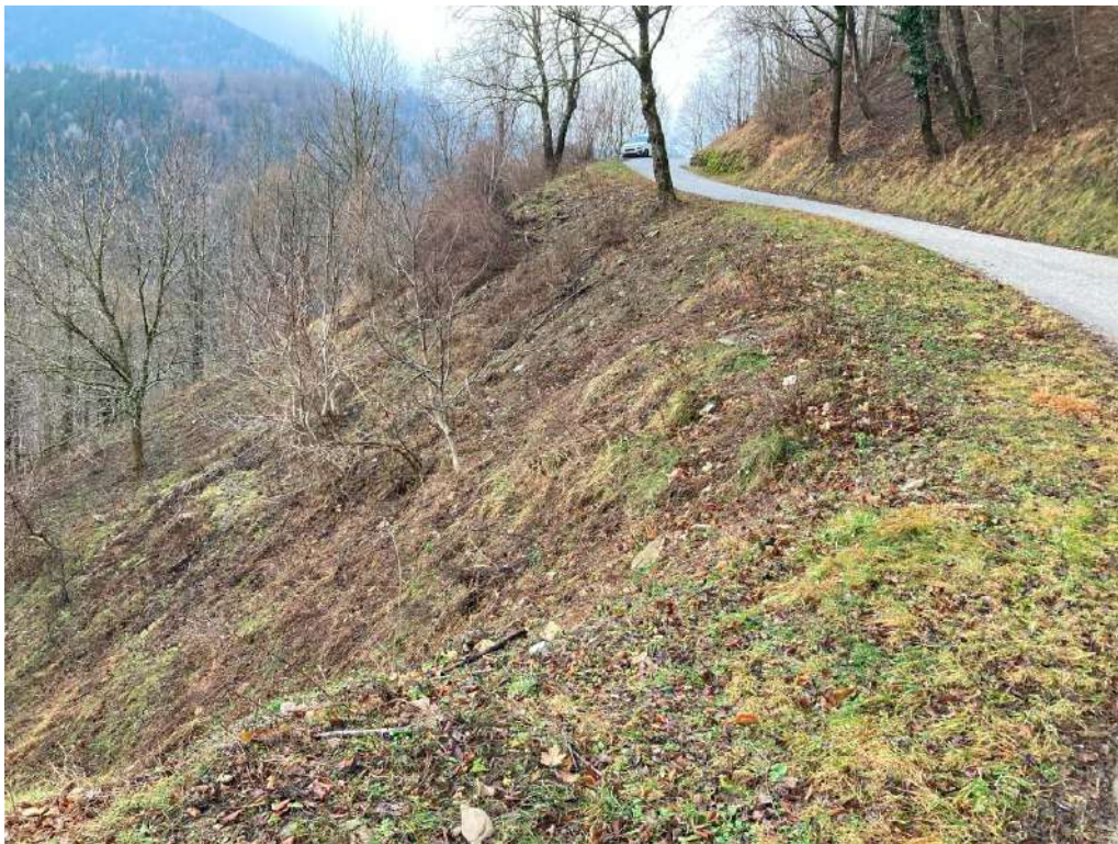
Slika 18: Spodnja brežina pod spodnjim delom ceste. V tej fazi ukrepi niso predvideni, saj so sloji preperine predebeli za lahke konstrukcijske ukrepe. Globalno stabilnost se zagotavlja z rešitvami v zaledju, s katerimi se zniža nivo podzemne vode oziroma iztok površinske na te brežine.
