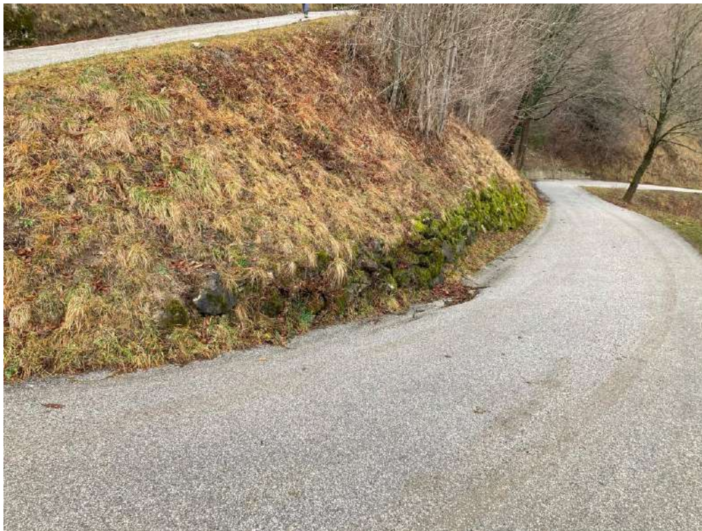
Slika 14: Obstoječ suhozid (zid kamen v suho) se ohrani. Predlaga se zamenjava v sklopu rekonstrukcije ceste. Globalna stabilnost ni vprašljiva, saj se dodatno zavaruje tudi zgornji rob z kamnitobetonsko gredo K-3.
