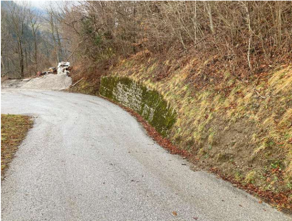
Slika 13: Zgornji del serpentine podpira betonski zid, v solidnem stanju (se ohrani).
