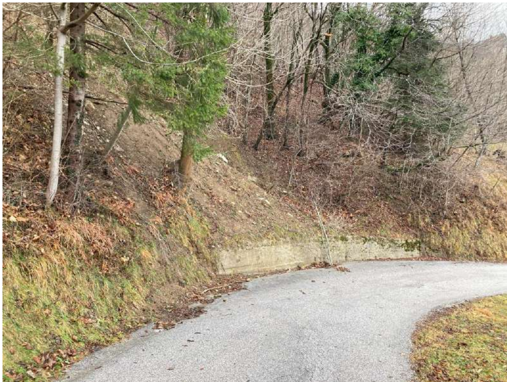
Slika 16: Obstoječ betonski zid, sicer večjih poškodb nima, a se ga nadomesti z globlje temeljenim kamnitobetonskim zidom zaradi dolgoročne globalne stabilnosti, tudi spodnje brežine pod cesto. Za zidom se izvede drenaža.
