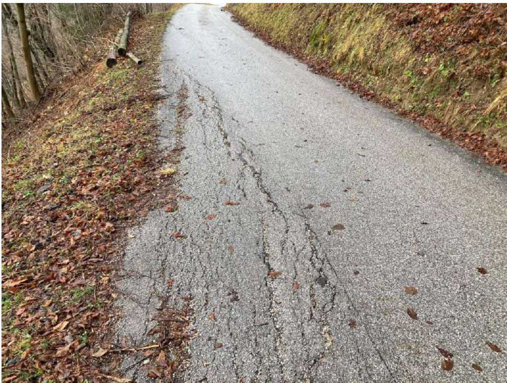
Slika 10: Poškodbe na vozišču nakazujejo na nestabilen zunanji rob. Predvidena sanacija s konstrukcijo K-3 (kamnitobetonška greda z vertikalnimi traverzami).
