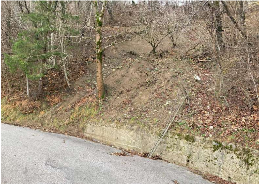
Slika 17: Pogled na osnovno plazino. Izrivni del je izklnil nad zidom (plitva, površinska, krožna porušnica).
