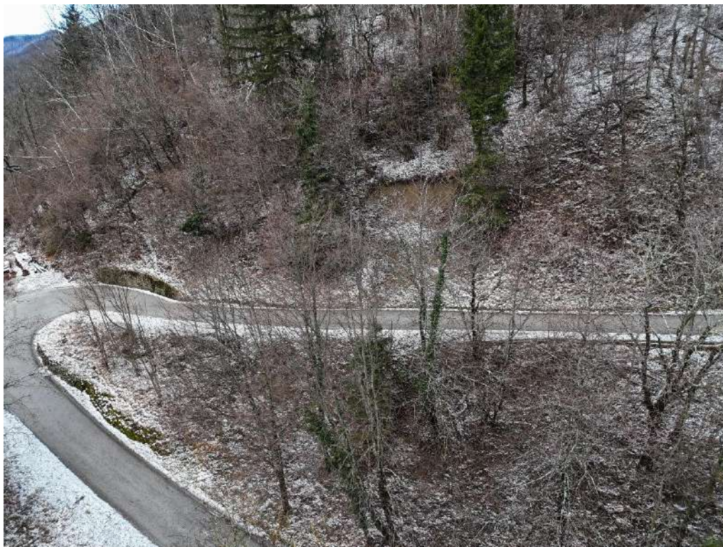
Slika 5: Manjši zdrs nad zgodnjim delom ceste za serpentino (predvidena konstrukcije K-2).
